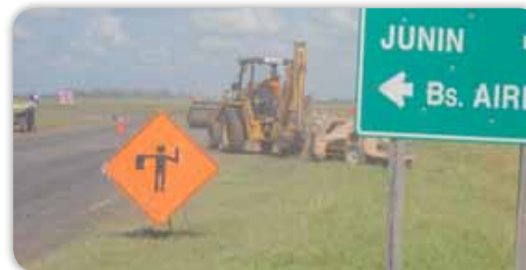
La Defensoría realizó mensualmente el monitoreo sobre el avance de las obras de reparación de la Ruta 31, en el marco de un proceso judicial.
