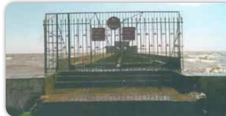
La Defensoría supervisó junto al municipio de Ensenada, a requerimiento de la Justicia, el cumplimiento de la sentencia que impuso instalar medidas de seguridad en el muelle de Punta Lara.
