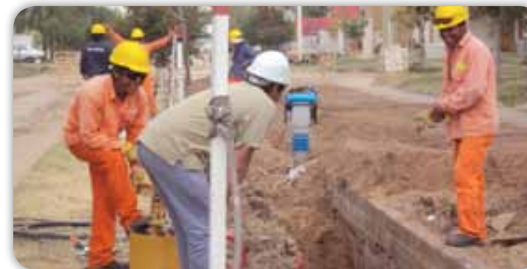
En el marco del acuerdo tendiente a mejorar la calidad del agua en 9 de Julio, la Defensoría verificó el cumplimiento de las obras comprometidas.
